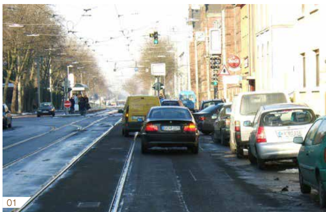
Fig. 01 et 02 : intersection entre la rue Hans-Thoma et la rue Stephanien, dans le sens de sortie de ville : il y avait initialement deux voies de tout-droit pour les véhicules motorisés. L'importante charge de trafic à l'heure de pointe du soir était particulièrement décisive sur la capacité du carrefour. Or, le pic en question s'était considérablement atténué du fait d'une plus grande
