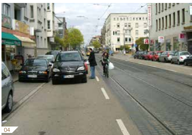
Fig. 04 et 05 : La situation de départ dans la Karlstrasse était la suivante : le tram bénéficiait d'un tracé en site propre au centre de la chaussée, avec, de chaque côté, une voie pour les véhicules à moteur, puis des voies pour la mobilité douce. Au fil du temps s'est développée la pratique du parcage en double file, amenant le tram et les véhicules à moteur à se partager l'es-
