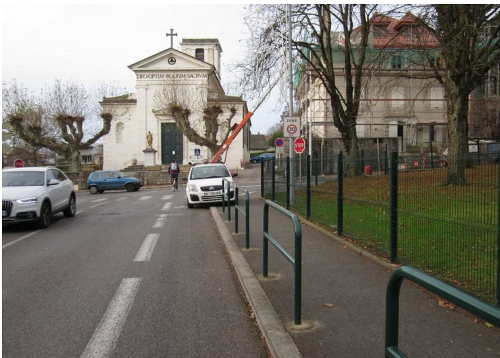
Illustration 1: Une barrière manquante permet à une voiture de bloquer la bande cyclable et le trottoir...
