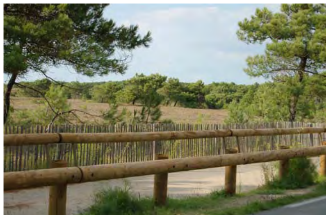
Glissière double-fonction avec réhausse, piste piéton-cycle RD 768 Le Bégo / Penthièvre (56)
