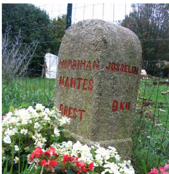
Photo 132 : borne rénovée, canal de Nantes à Brest
