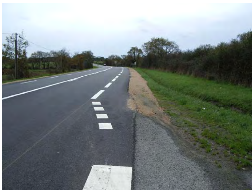
Marquage d'entrée sur une B.D.M. RD780 Vannes – Arzon (56)
