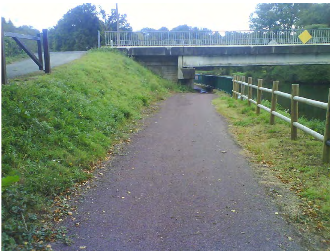
Photos 101 : Passages inférieurs réservés aux cycles et piétons, canal de Nantes à Brest (56)
