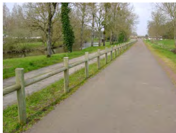
Lisse simple AVEC extrémité saillante, Voie verte Questembert – Mauron (56)
