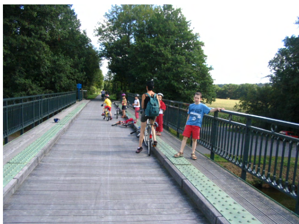
Garde-corps sur ouvrage avec trottoir, voie verte Questembert - Mauron (56)
