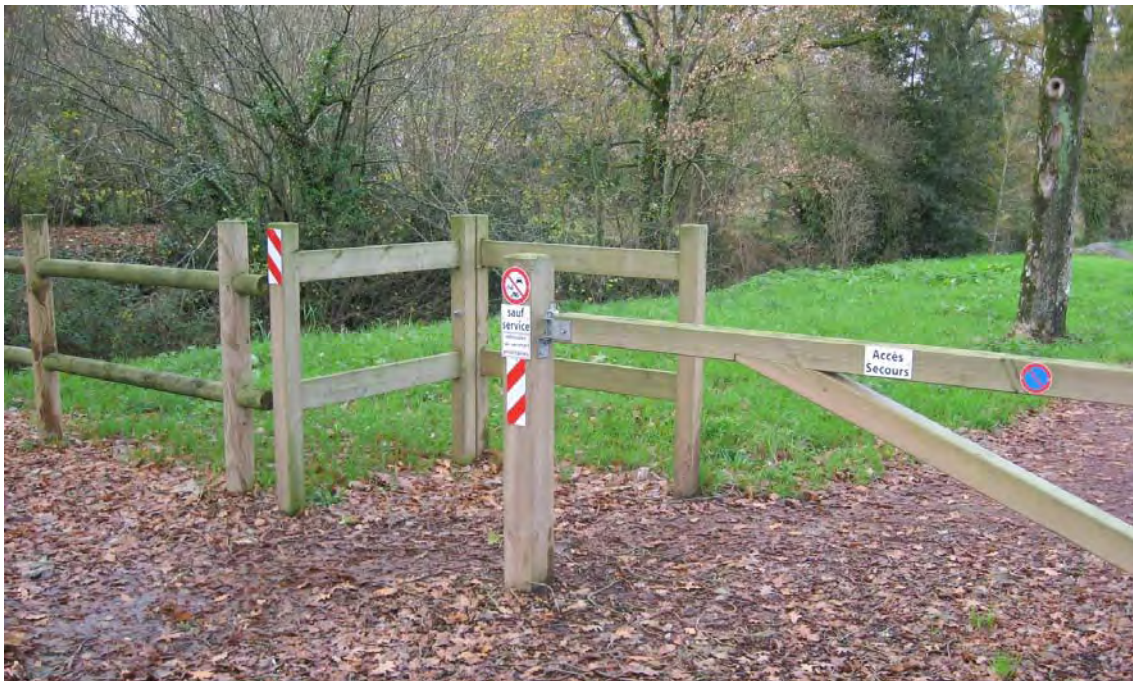
Photo 151 : Plaquette HI sur contrôle d'accès - canal de Nantes à Brest (56)
