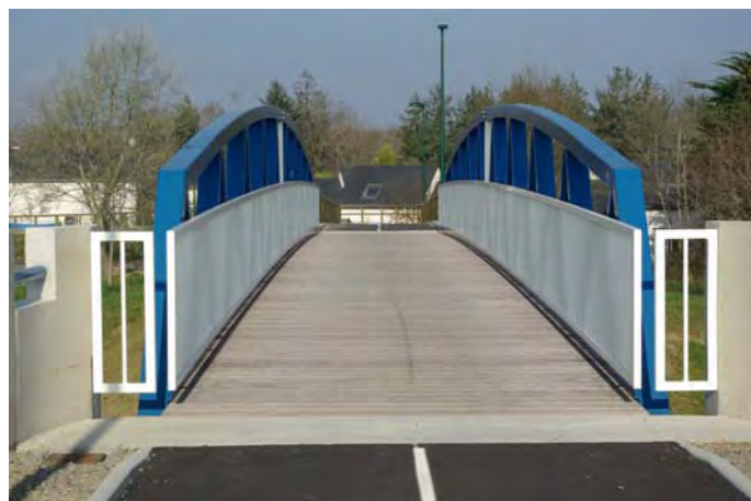
Garde-corps sur ouvrage piéton-cycle sans trottoir, Passerelle sur RD780 presqu'île de Rhuys (56)
