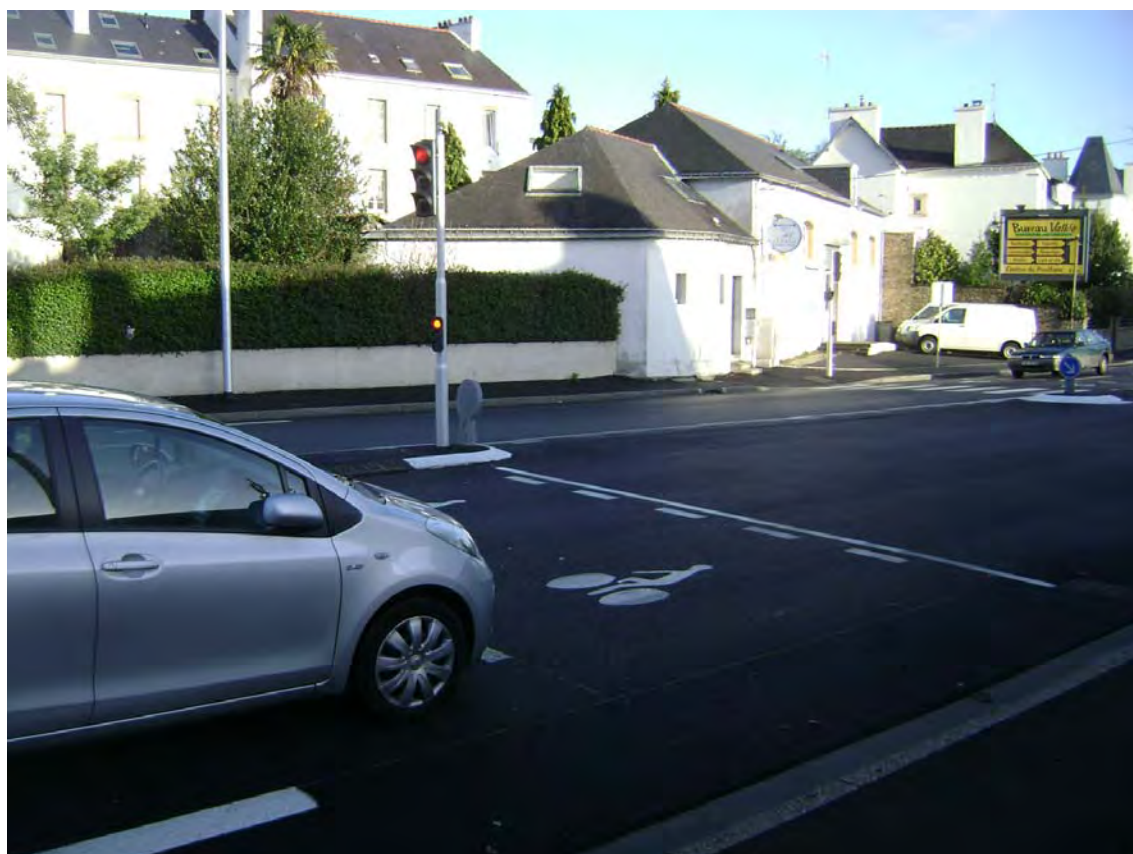
Photo 78 : Bande cyclable et sas dans un carrefour à feux sans passage piéton, Vannes (56)
