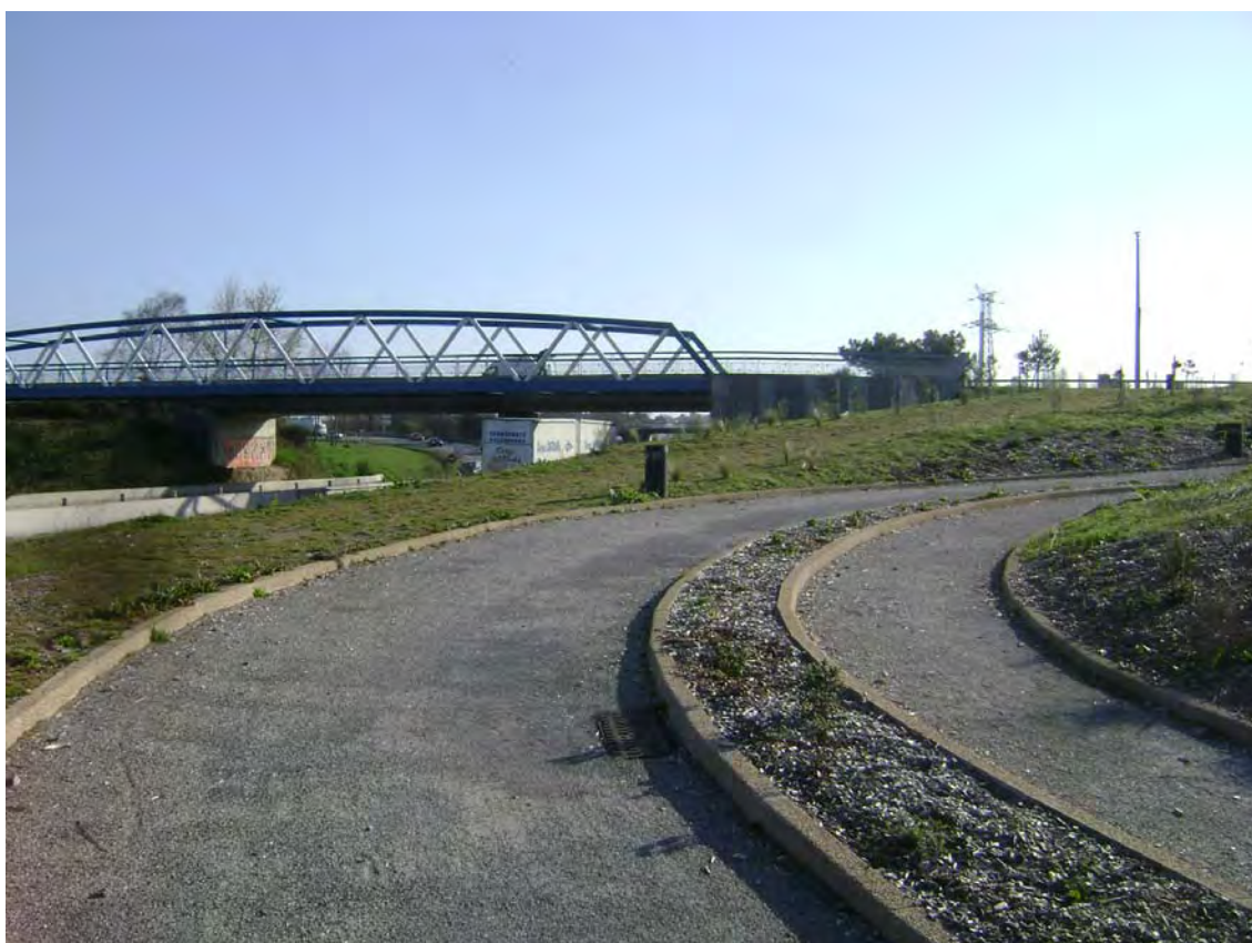
Photos 102 : Rampe d'accès à la passerelle piéton-cycle sur la RN165-E60, Lorient (56)
