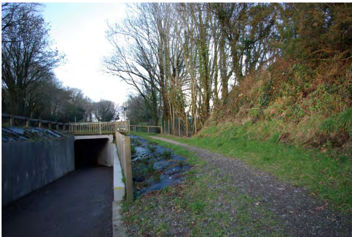
Voie verte Lorient / Pont Scorff - passage inférieur sous la RD6, Pont Scorff (56)
