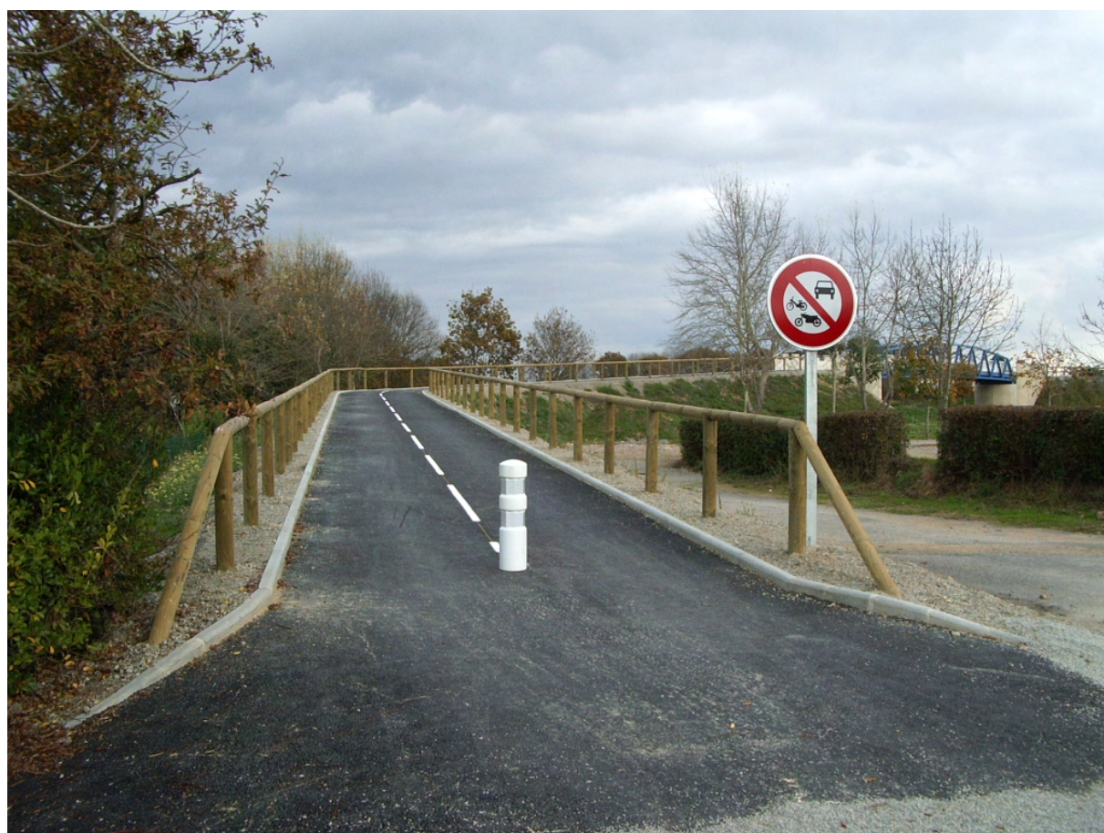
Photos 103 : Rampe d'accès à un passage supérieur, St Colombier sur la presqu'île de Rhuy (56)
