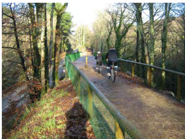
Ouvrage d'art sans trottoir, Voie verte Quéven – Pont Scorff, Keruisseau (56)
