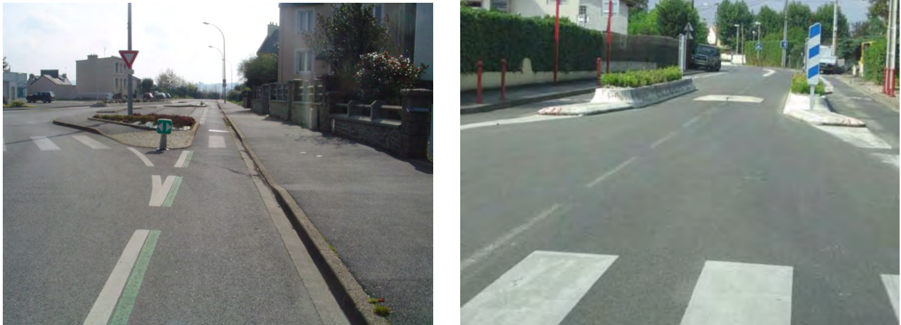
Photos 15 : By-pass à un passage piéton avec effet porte et réduction de voirie, extérieur Morbihan
